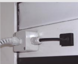
bezpečnostní lišta s gumovým těsněním, která při stlačení zareaguje vypnutím motoru
