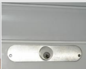
zámek zajišťující pancíř proti nadzvednutí se používá při ručním ovládní vrat
